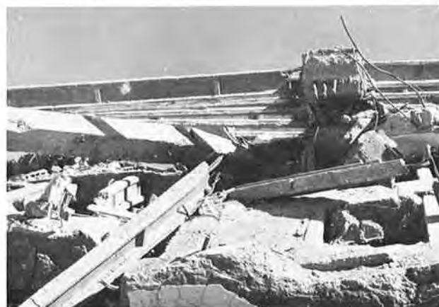
Fig. 42. Precast Floor Beams Used in the Immeuble Consulaire
